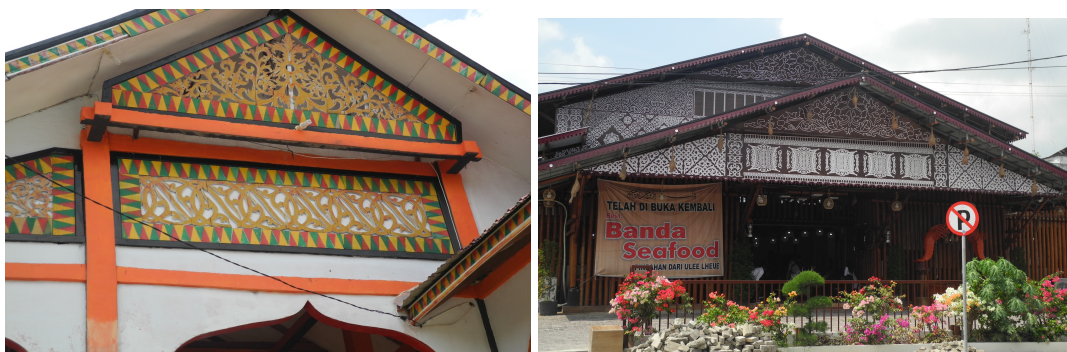
Gambar 4. Ornamen Rumah Tradisional Aceh yang telah mengalami transformasi. Seharusnya ornamen pada rumah tradisional Aceh dibuat dengan teknik ukir, Tidak di gambar atau di lukis, terjadi perubahan pada material, selain itu fungsi bagian atas yang dihiasi ornamen sebagai sirkulasi udara, pada gambar diatas mengalami perubahan fungsi sebagai penghias saja.
