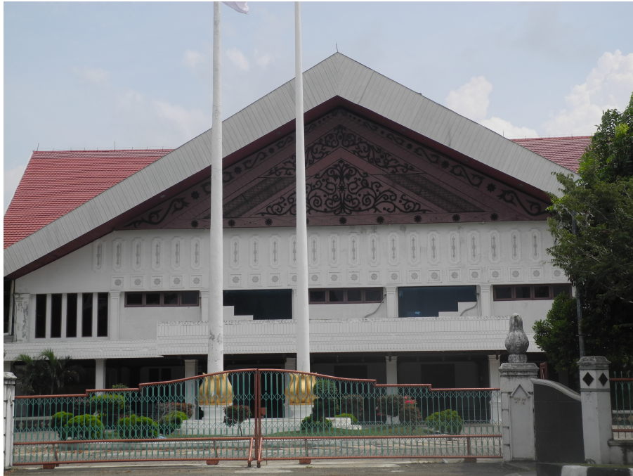
Gambar 5. Ornamen yang terdapat pada kantor dewan perwakilan rakyat aceh yang mengalami perubahan dari aspek material. Material dalam membuat ornamen di kantor ini menggunakan material semen dengan teknik relief.
