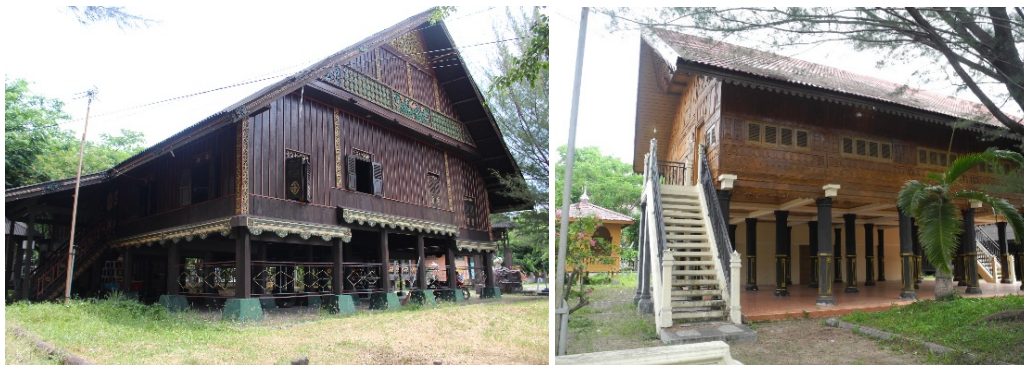
Gambar 2. Rumah tradisional ini terletak di Taman Ratu Safiatuddin Banda Aceh. Rumah ini sudah mengalami transformasi pada atas, semula menggunakan daun rumbia kini berganti dengan seng, bagian tiang yang semula menggunakan kayu kini berganti dengan material semen.
